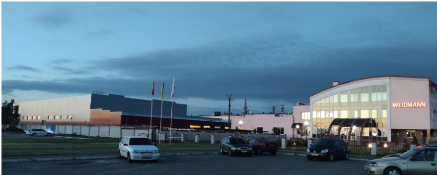
Foto 4: Electrical Technology – Produktions-Standort in Malyn (Ukraine)
